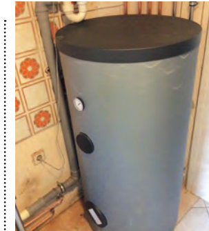
Ein neuer Pufferspeicher kommt rein und der Ölbrenner kann weg.
