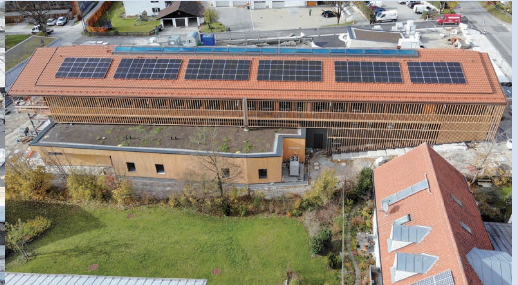
Ostseite: die Fassade ist fertiggestellt.
