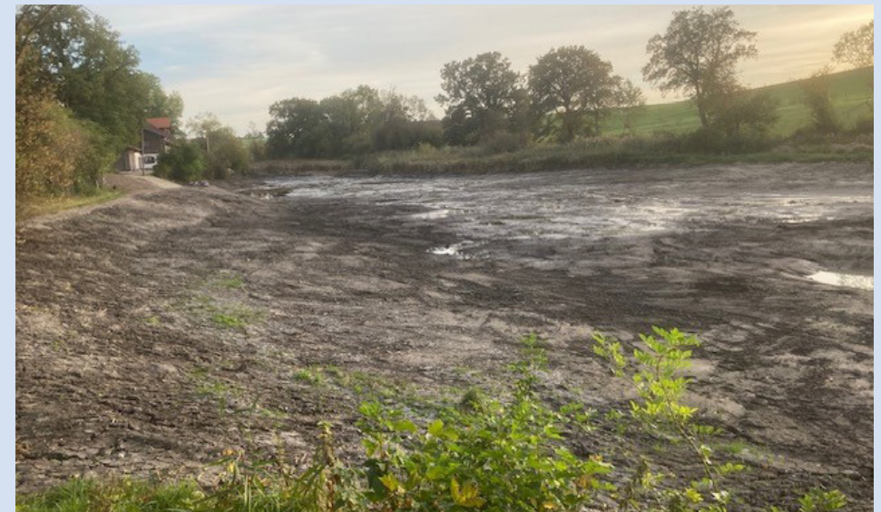
...und nach Abschluss der Aushubarbeiten. Nun fehlt nur noch der „Mönch“ zur Abflussregulierung.
