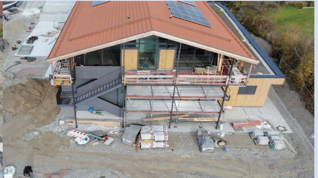
Südseite: Die Treppenanlage ist in Arbeit.
