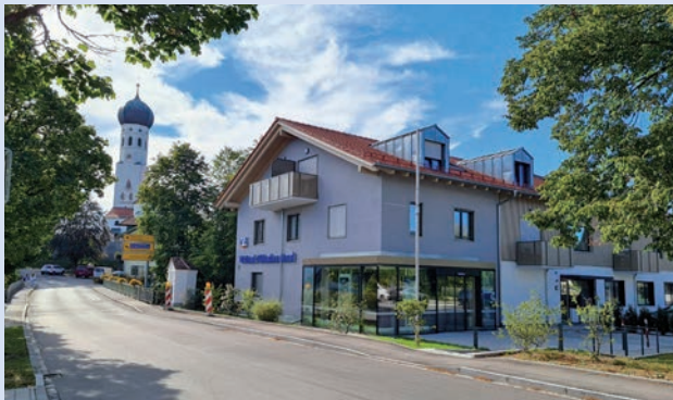
Der Gehweg vor der VR Bank wurde saniert und angepasst.
