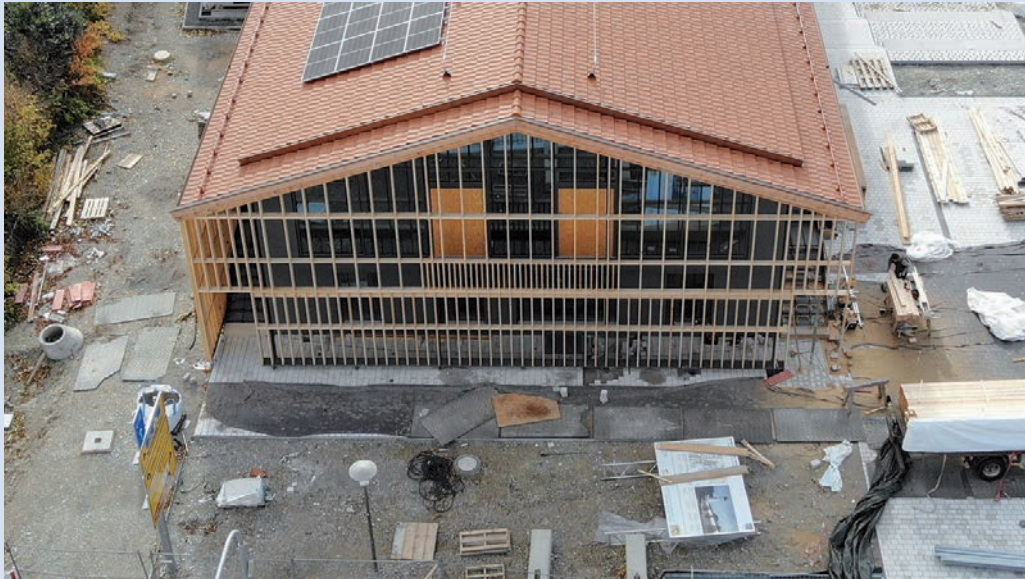
Nordseite: Der Fassadenvorhang ist fertiggestellt.
