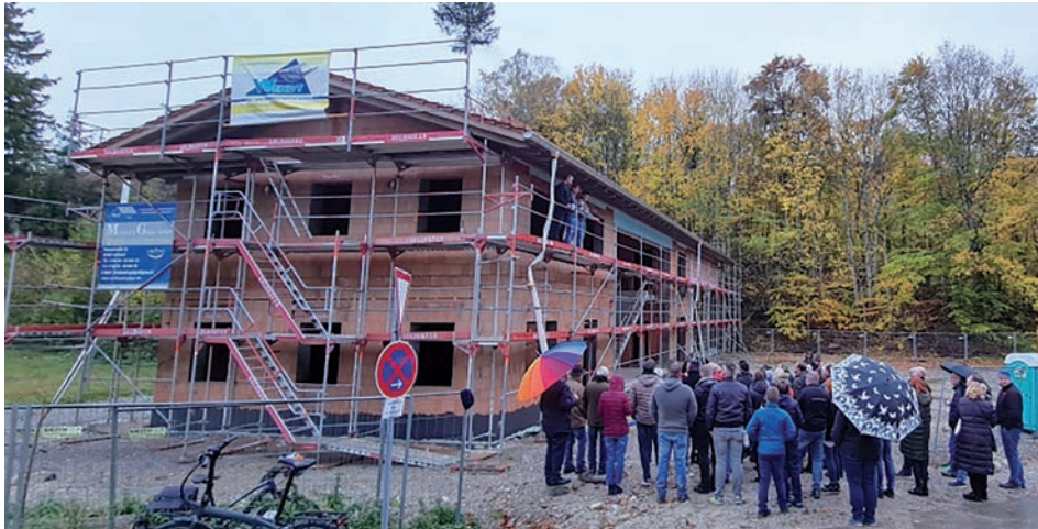
Das neue Ammerlander Feuerwehrhaus am 3. November: Der Rohbau steht und das Dach ist gedeckt.
