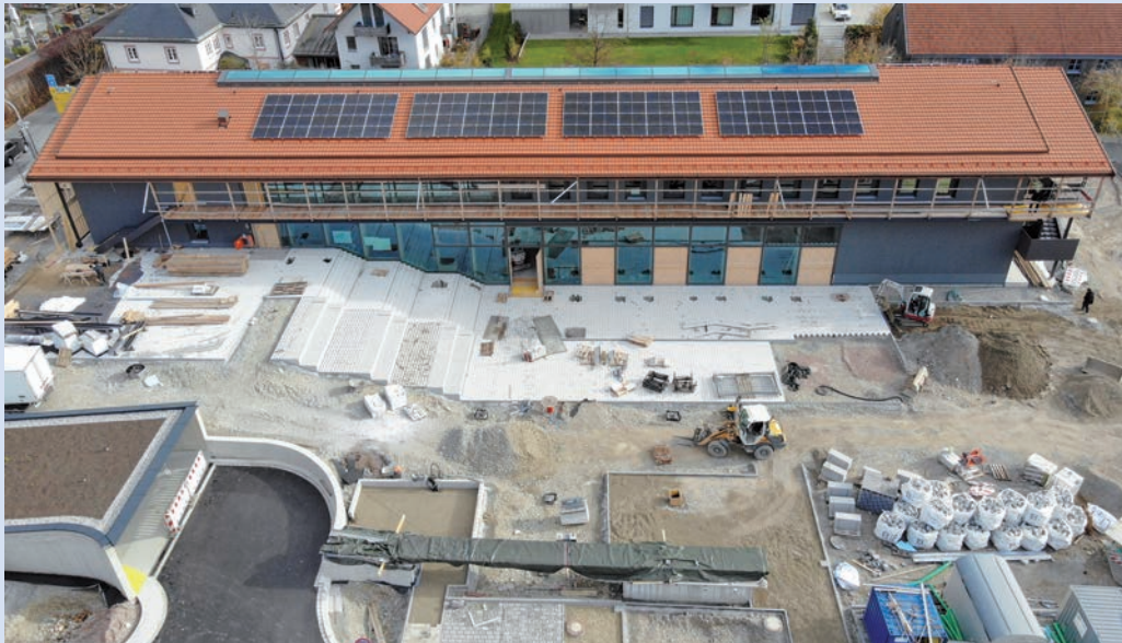
Westseite: Treppenanlage und Pflasterarbeiten sind fertiggestellt, die Parkplatzstellflächen in Arbeit.
