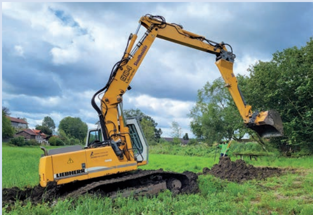
Experte am Werk: Andreas Sindlhauser mit seinem Spezialbagger.
