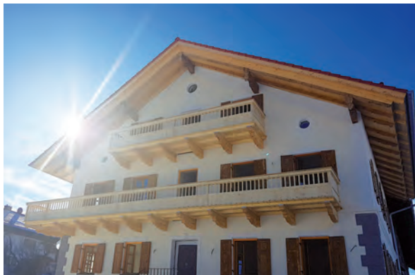
Komplettsanierung 140 Jahre altes Bauernhaus in Degerndorf
