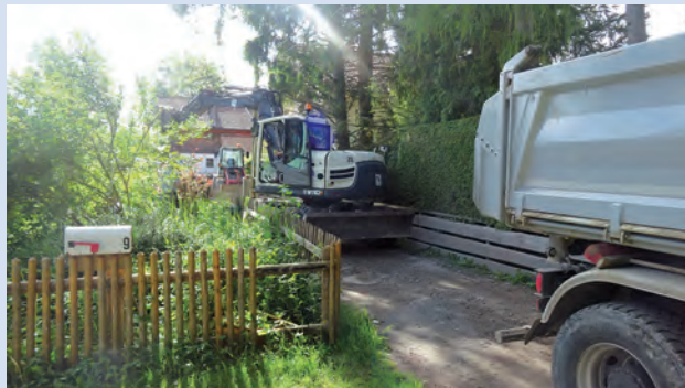
Aufgrund der Enge kompliziert: die Baumaßnahmen am Erlenweg.
