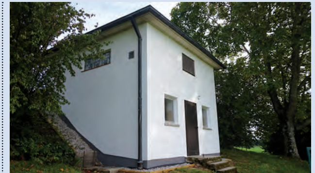
Erhielt ein „Facelifting“: der Hochbehälter am Kammerloh.
