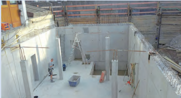
War nötig für den Einbau des Pufferspeichers: ein tiefer Aushub.
