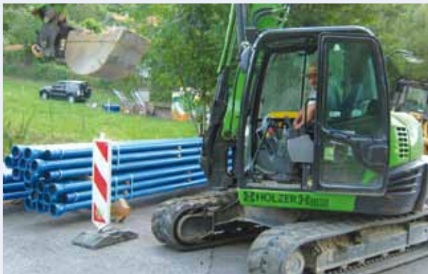
Potenzielle Rohrbruchregionen wurden konsequent saniert: neue Leitungen für den Ambacher Simetsberg.
