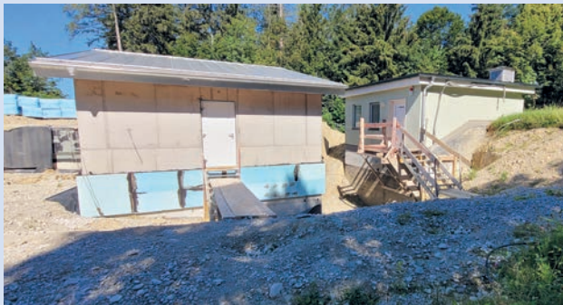
Weidenkam: Noch steht der alte Behälter (re.) neben dem Neubau.
