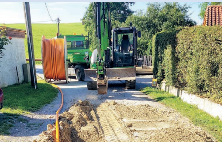
Wasserleitungsbau in der Bachstraße: Netzausbau mit vorbereitet.
