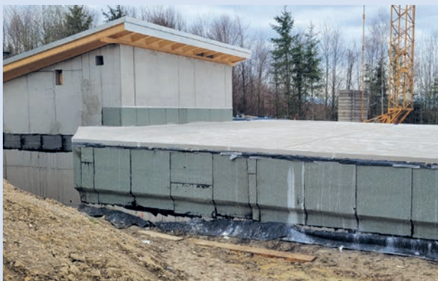
Der neue Trinkwasserbehälter vor der Verfüllung.
