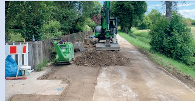
Der beim Leitungsneubau in der Bachstraße gewonnene Aushub...
