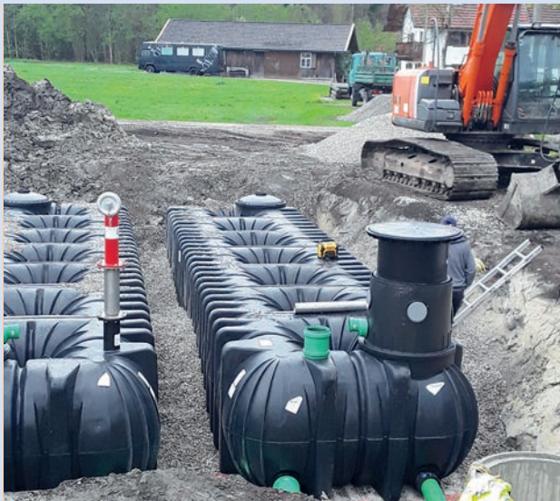
Riesige Löschwasserbehälter wurden in Schechen vergraben.
