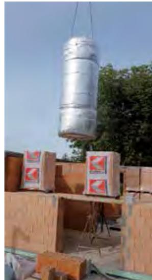
Wurde bereits während der Rohbauphase eingebaut: der große isolierte Stahltank.
