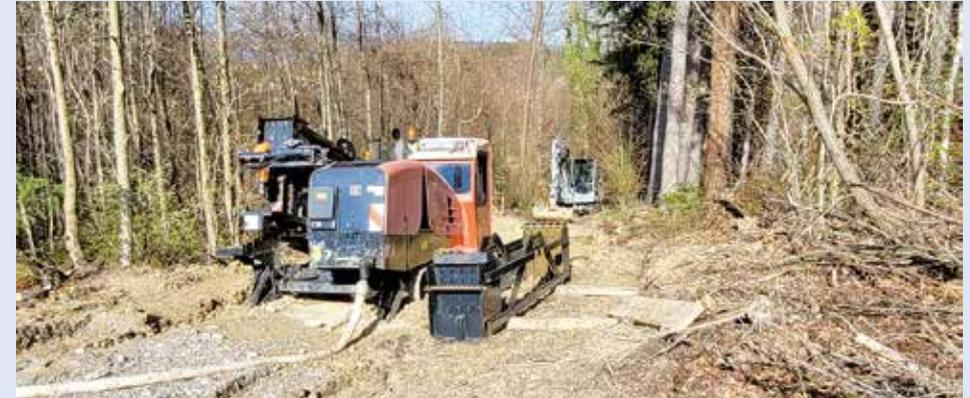
Moderner Leitungsbau: auf 360 Metern wurde das Spülbohrverfahren angewendet.
