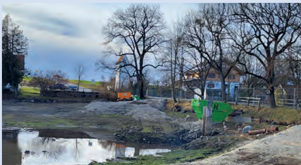
Die rechts auf dem Damm stehenden Bäume mussten weichen.
