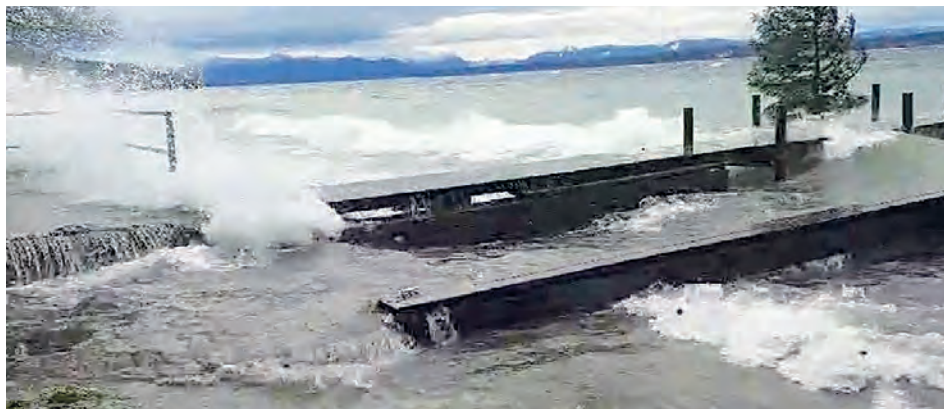
Starker Wellengang und Sturm richteten an der Wachstation große Schäden an.
