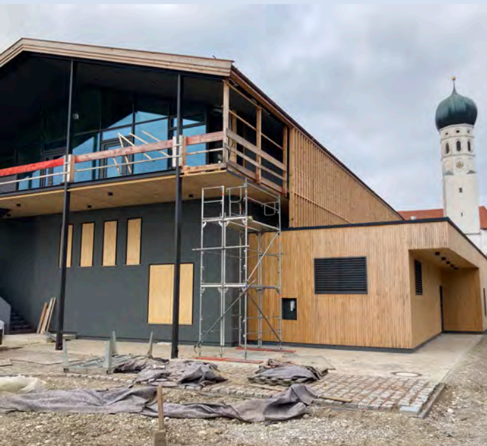
An der Südseite sind die Fassadenarbeiten noch im Gange.
