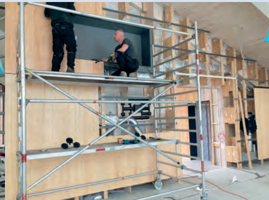
Montage der Monitorwand im Sitzungssaal.
