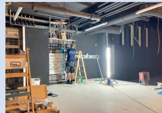
Bühnen-Nebenraum mit Technik.
