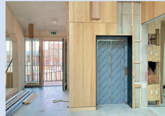
Aufzugseingang im 1. Obergeschoss.
