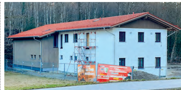
Das neue Feuerwehrhaus in Ammerland Nord/Ostansicht.
