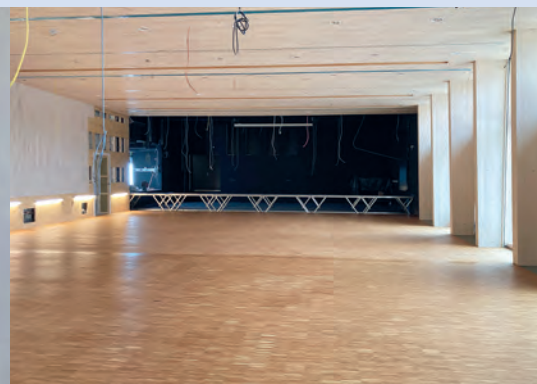
Pallaufsaal mit fertigem Parkettboden.
