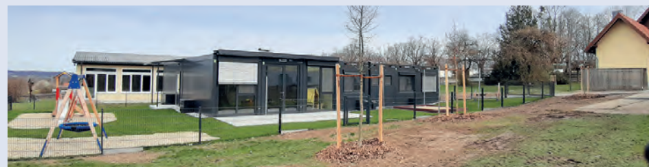
Wurde übergeben: die Containeranlage für die Kinderkrippe im integrativen Montessori-Kinderhaus Aufkirchen.
