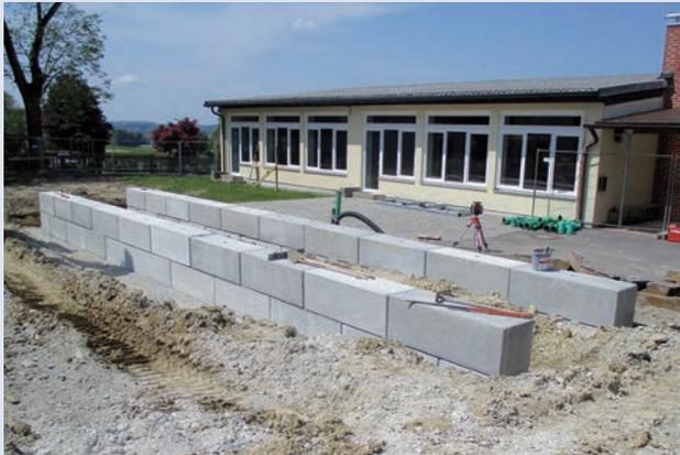
Zunächst wurden von Bauhof die Betonfundamente gesetzt, ...
