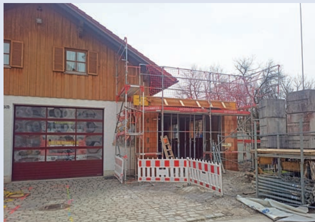
Der Rohbau ist fertig: Erweiterungsbau der FFW in Bachhausen.
