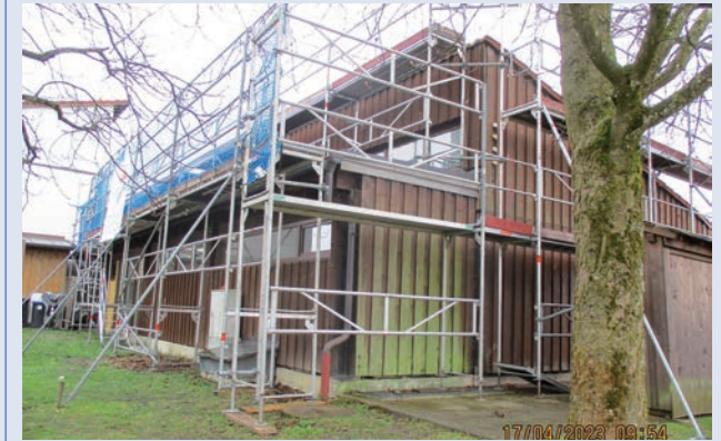
In vollem Gange: Die Sanierungsarbeiten an der MTV-Tennisanlage.
