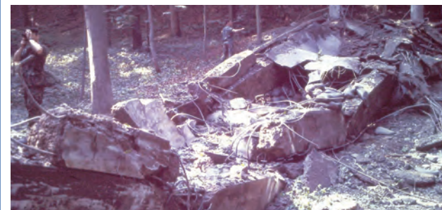
... Seeburg, wurde aber 1984 wegen ihres schlechten Zustands gesprengt.
