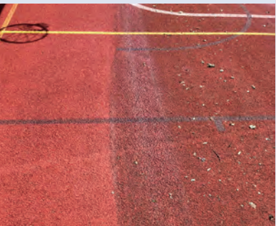
Bereits nach einmaliger Befahrung wird der Reinigungseffekt deutlich.
