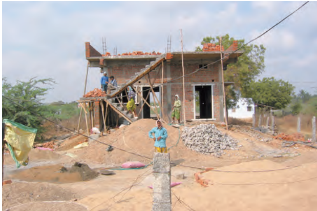
Eines der 240 Häuser, deren Bau der Eine-Welt-Kreis unterstützt hat.
