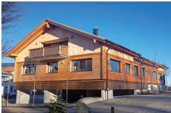
Neubau Bürogebäude mit Holzfassade in Münsing
