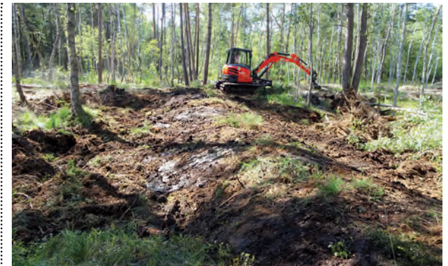
Noch ohne Stauwasser: der neue Damm im Münsinger Filz.
