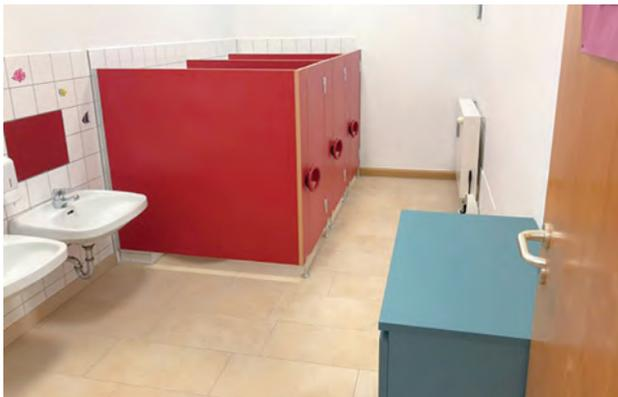
Die 40 Jahre alten Standtoiletten wurden durch neue Hängeschüsseln ersetzt, die Spülkästen verschwanden in einer neuen Verschalung, der Boden wurde neu gefliest und die Trennwände zwischen den Toiletten wurden neu beschafft und montiert.
